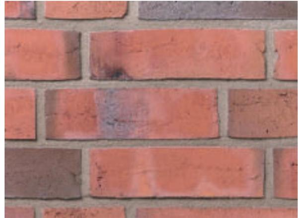
Abb. 21 Unbesandet, nicht künstlich strukturierter Wasserstrichziegel (Handstrich) mit heller Fuge, Farbe: rotbunt
