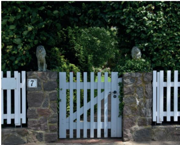
Abb. 41 Staketenzaun mit gemauerten Torpfeiler aus Naturstein
