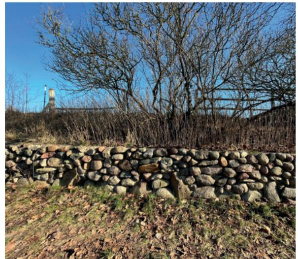
Abb. 43 Einfriedung aus Naturstein, trocken aufgesetzt
