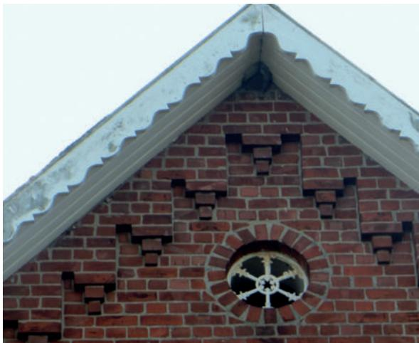
Abb. 17 Dachabschluss mit verziertem Stirn-, Unterschlags- und Windfederbrett
