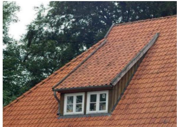
Abb. 14 Schleppdachgaube mit seitlicher Holzverschalung
