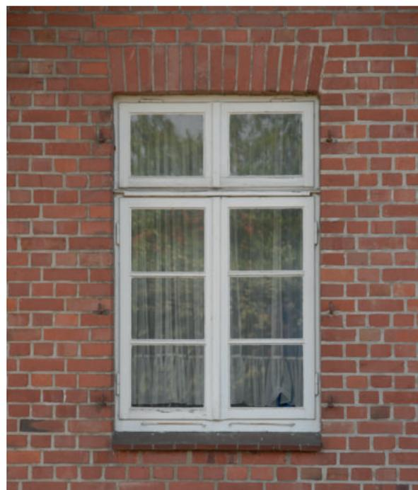
Abb. 30 Fenster mit einfacher Sohlbank
