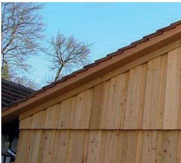
Abb. 18 Dachabschluss mit Zahnleiste
